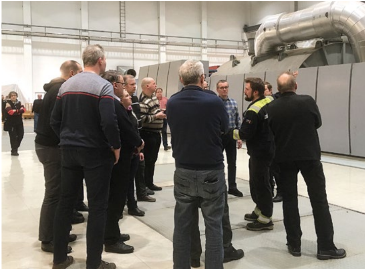
Yritysvierailu Seinäjoen Voiman voimalaitokselle keräsi runsaan osanottajamäärän.
