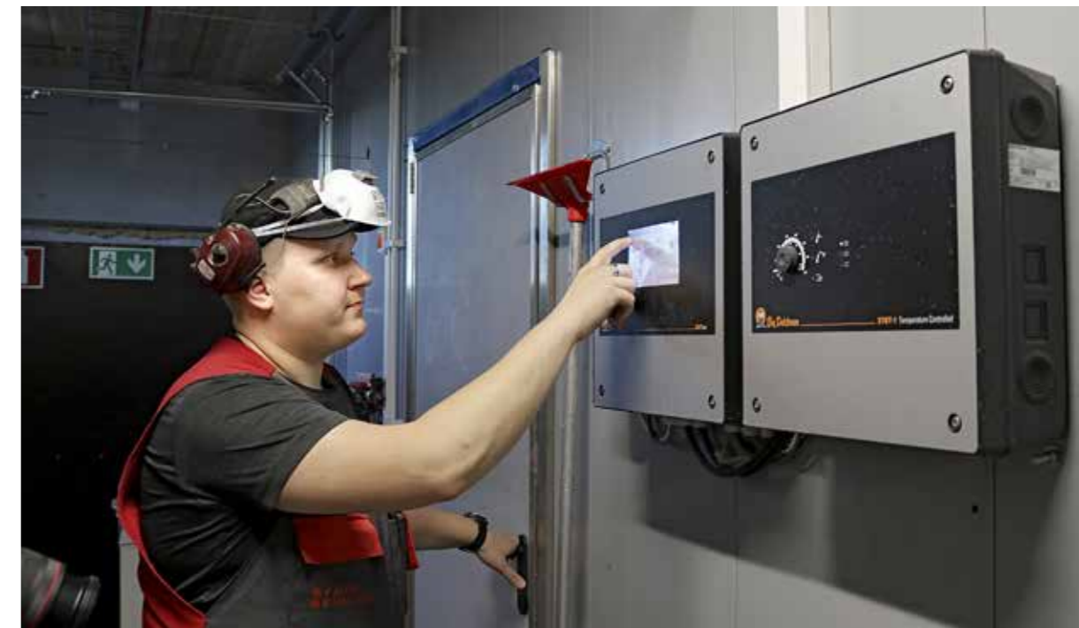
Tekniikalla on iso rooli nykyaikaisessa kotieläintuotannossa, ja siksi varaosien saatavuudellakin on merkitystä huoltovarmuuteen.
